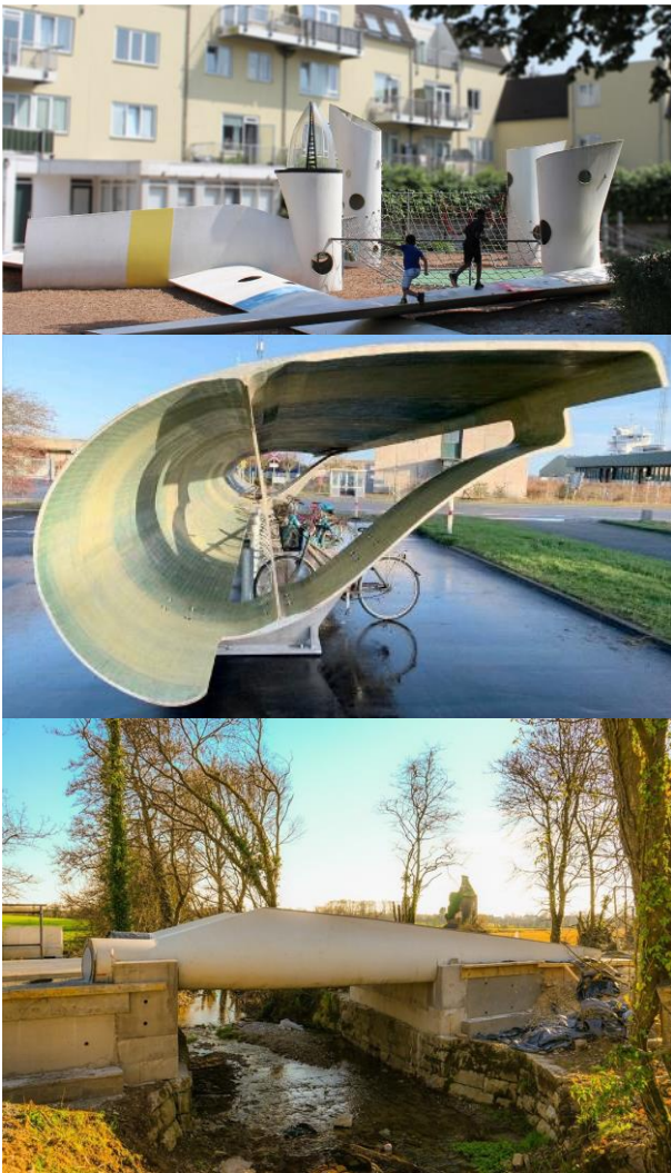
شکل ۵. استفاده از پره‌های از کارافتاده در پارک، پارکینگ دوچرخه و همچنین پل (Joustra et al., 2021)
